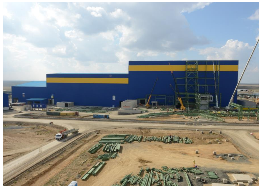
Строительство обоганительной фабрики Бозшаколь, 2014 год
