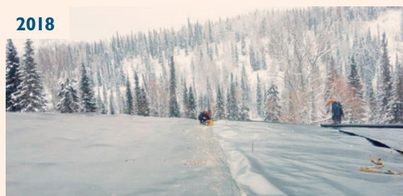
Geomembrane installation
