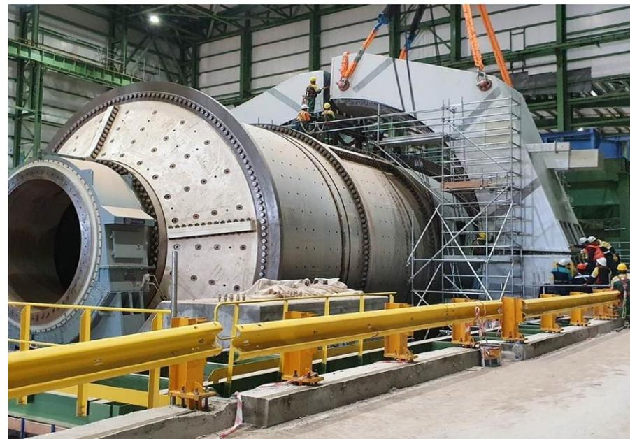
Установка шаровой мельницы 1 БПМ, август 2020 г.
