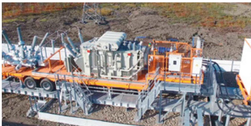
Строительная линия электропередачи и подстанция на 110кВ на объекте Баимская
