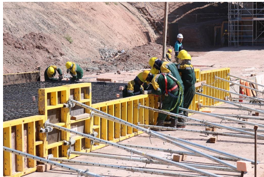
Строительство Актогая II, июнь 2019 г.
